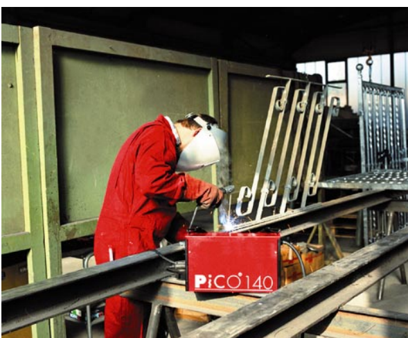
Bild 22 Anwendung des E-Hand-Schweißens beim Geländerbau
