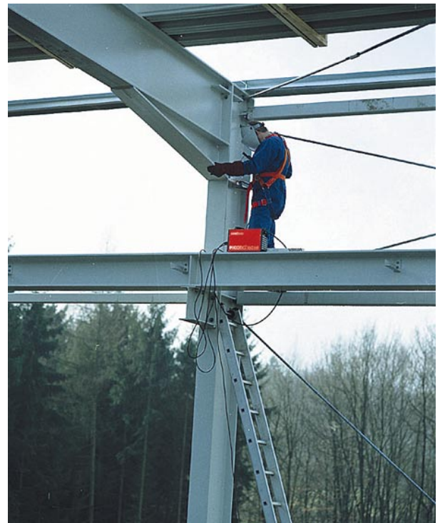
Bild 20 Einsatz der Inverter-Schweißstromquelle PICO 140 (4,6 kg / 140 A) auf der Baustelle
