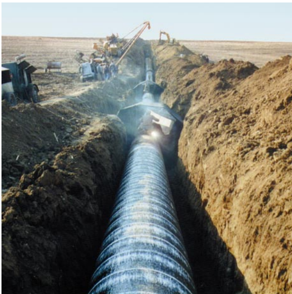
Bild 6 Schweißen im Rohrleitungsbau mit Zellektroden
